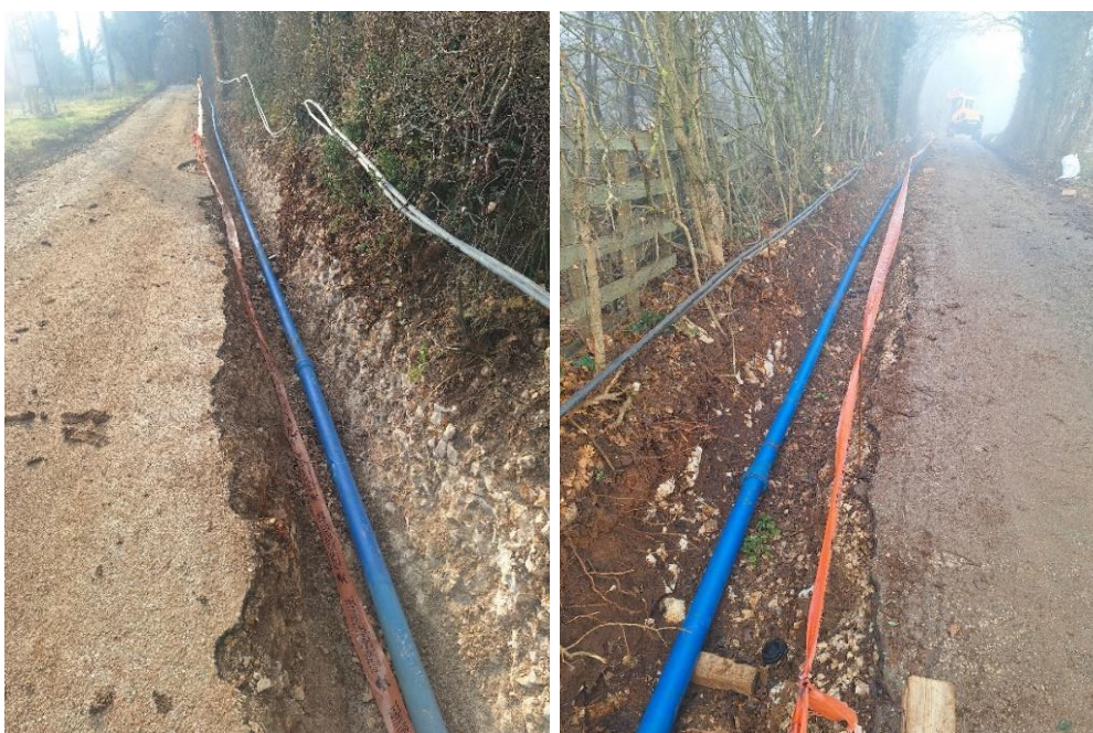
SLIKA 6. RADOVI U NASELJU BLAŠKOVIĆI
