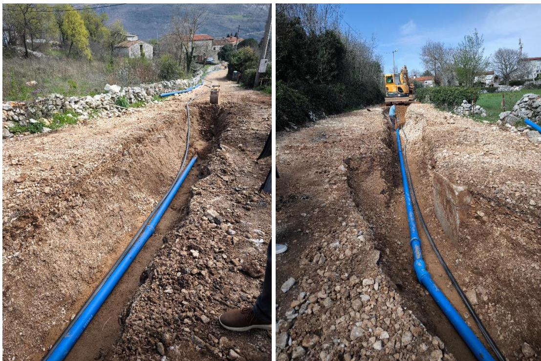
SLIKA 8. SANACIJA DOTRAJALOG CJEVOVODA U NASELJU STEPČIĆI
